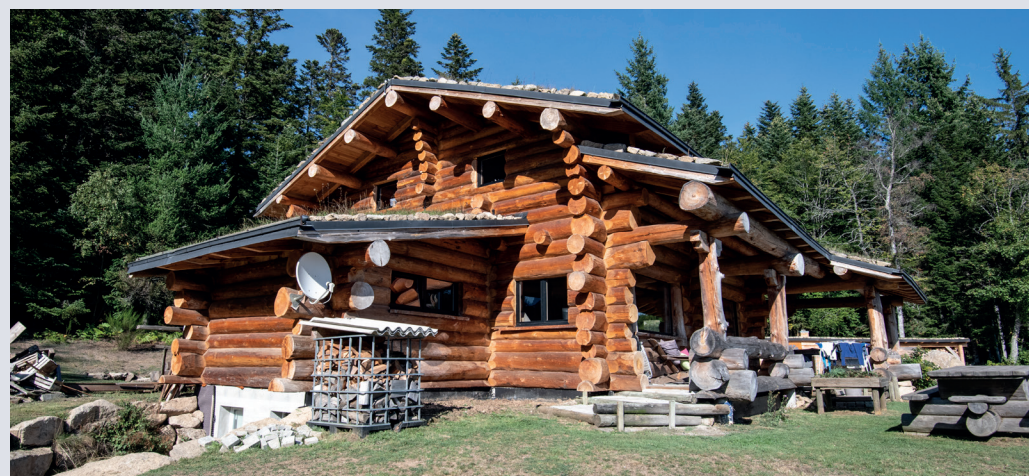
Concevoir la maison en fonction de son environnement, l'intégrer au mieux dans le site est une nécessité pour la réussite d'un projet et surtout pour la protection naturelle qu'offre le bois brut. Car aucun traitement, type lasure, n'est nécessaire sur une fuste.
